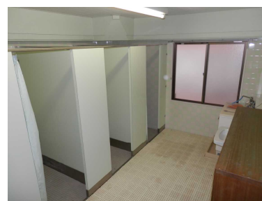
〈別館シャワー室〉
