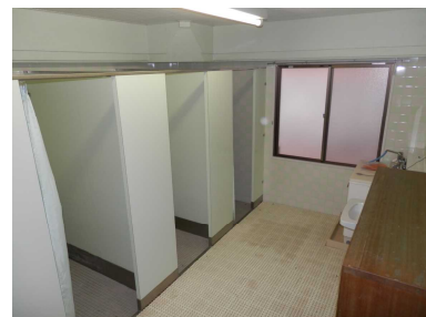
〈別館シャワー室〉
